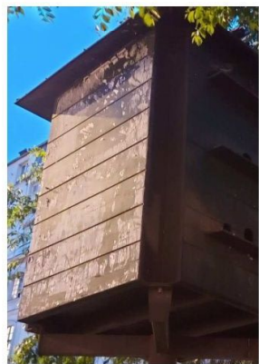
Paris (11 e ), rue Réaumur, le 20 avril. Situé à l'ombre d'un arbre géant, le pigeonnier contraceptif est monté sur pilotis.
